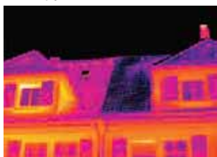
Проверка теплоизоляции в области крыш и слуховых окон
