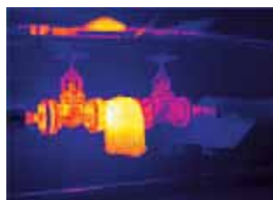
Проверка функциональности паропроводящих труб
